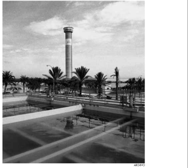
Planta potabilizadora de l'Ampolla
